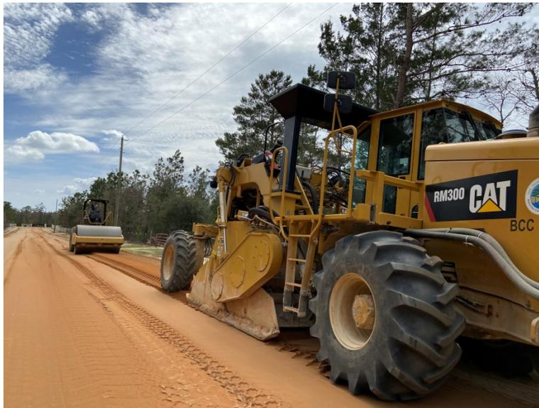
5. Compactar utilizando rodillo vibratorio liso de 12 toneladas y o compactador de placa hasta conseguir densidad máxima. Usualmente se alcanza en tres a cuatro pases.
