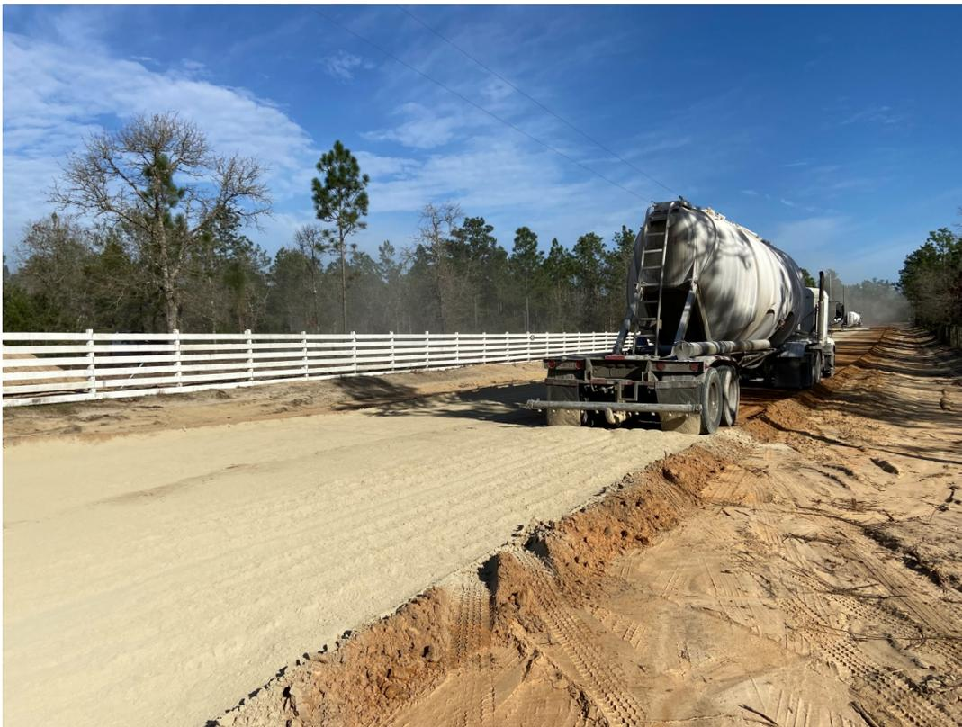
Asegurarse de esparcir el aditivo homogéneamente utilizando la motoniveladora o labor manual.
